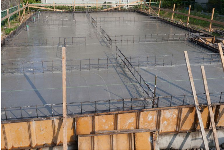
Curado de hormigón
