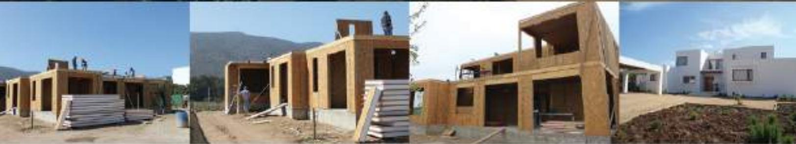
El Panel SIP (Structural Insulated Panel), es un moderno y completo sistema estructural auto soportante usado para la construcción, conformado por un alma de espuma rígida de Poliestireno de alta densidad (EPS).
