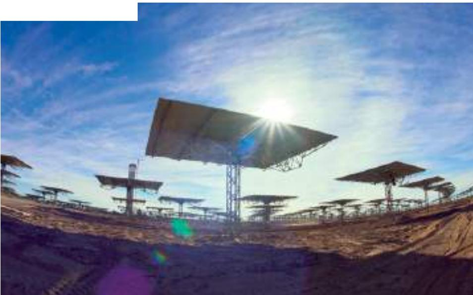
Cada heliostato está conformado por 32 espejos que siguen la trayectoria del sol con un movimiento en dos ejes.
