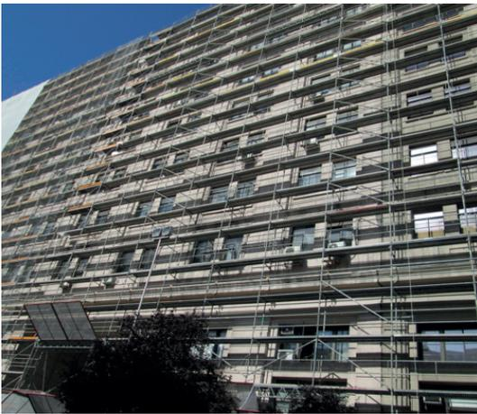
DORPA, Sistema de andamio de marco, para realizar trabajos en fachadas, permitiendo abordar con total seguridad las diversas configuraciones que se presentan en obra, trabajos de revestimientos, mantenimiento y albañilería en general.
