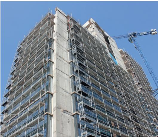
Sistemas de marcos con gran capacidad de carga, de fácil montaje, gran capacidad para adaptarse a las distintas formas y altura de las fachadas.
