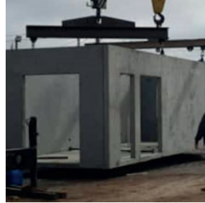
Módulos de hormigón
