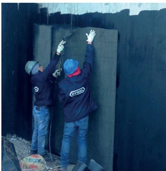
Sistema de Impermeabilización, compuesto por una membrana asfáltica y una lámina drenante.
