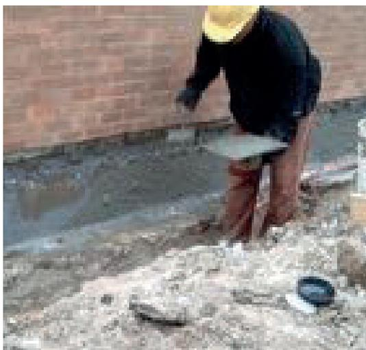
SELLENITE-700RLISTO es un aditivo líquido, multi componente, en dispersión acuosa altamente resistente a substratos alcalinos Solución cementicia impermeable para juntas de construcción (juntas frías) y superficies contra terreno evitando ascensión por capilaridad.
