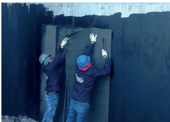
MEMBRANA ASFÁLTICA JD2 PLUS ARE es modificada con Polímeros de SBS, de alto rendimiento para impermeabilización en climas templados-fríos. Membrana JD2 Plus ARE es fabricada bajo el Sistema de Gestión de Calidad ISO 9001:2008.
