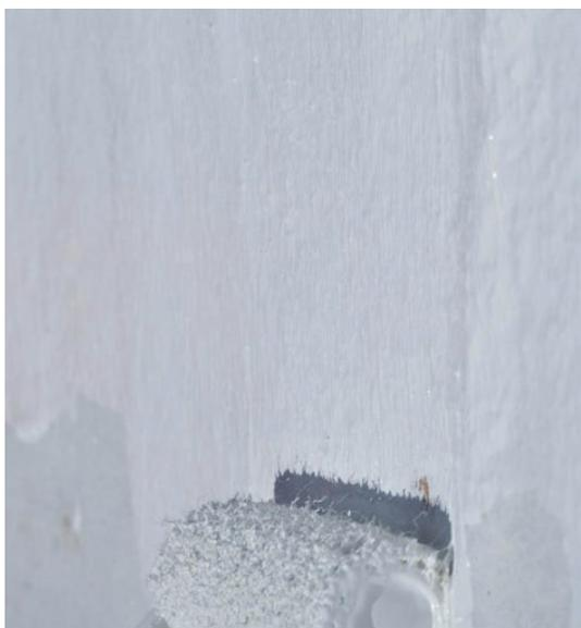
SELLENITE-288 es una membrana impermeable que se forma in situ. Formulada en base a polímeros en dispersión acuosa, cargas, plastificantes y conservantes entre otros, de viscosidad media, y altamente elástica (800%). No contiene asfaltos, ni solventes. SELLENITE-288 forma una lámina flexible y resistente con una excelente adherencia a distintos materiales como hormigón, estucos, albañilerías, fierro galvanizado, aluminio, vidrio, acero, etc.
