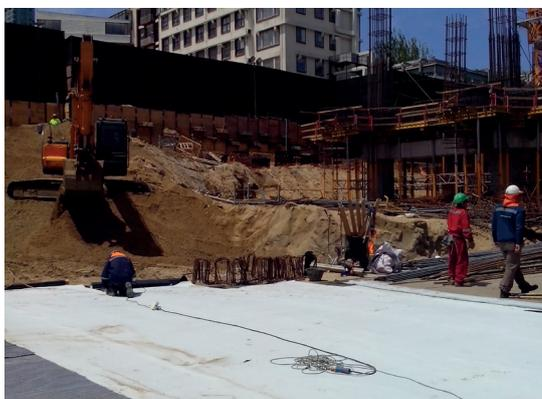
DANOPOL FV NI 1.5 es una lámina sintética a base de PVC plastificado para impermeabilización. Esta lámina NO es resistente a la intemperie y los rayos U.V. Puede trabajar independiente o formar parte de un sistema integral de impermeabilización, aislamiento térmico y drenaje.
