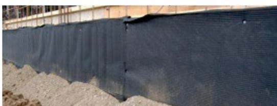
Las LÁMINAS DRENANTES poseen HDPE, lo que les otorga, elevada resistencia a la tracción y a la compresión, tanto de la presión hidrostática como del terreno. Dependiendo las características de la obra será la lámina que se recomienda instalar. Estas láminas proporcionan un drenaje permanente, evitando la colmatación del sistema de drenaje.
