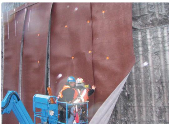
Las LÁMINAS DRENANTES están formadas por una lámina de plástico impermeable con una estructura tridimensional (tope-rol), para drenar las guas del terreno a la evacuación inferior, pueden además encontrarse acompañadas de un geocompuesto adherido para la contención del sustrato del terreno. La combinación de una membrana impermeable y el boquete de aire proporcionan un descanso confiable, capilar.
