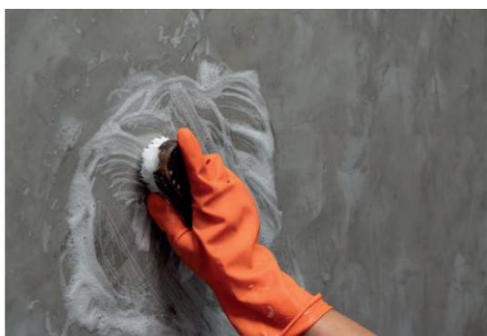
SelleNite Fuganeutro debe agitarse antes de su uso. La aplicación podrá realizarse mediante rodillo, brocha o escobilla. Se debe mojar bien la superficie para remover los restos de desmoldante.
