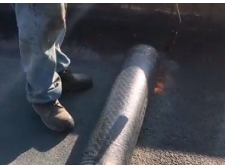
IMPERMEABILIZACIÓN CON MEMBRANA ASFÁLTICA PREFABRICADA
