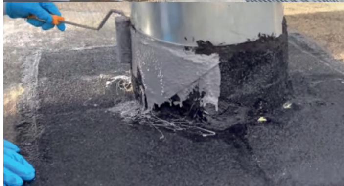
IMPERMEABILIZACIÓN A BASE DE POLIURETANO
