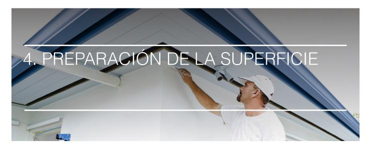
La preparación de la superficie depende del sustrato sobre el cual se aplicará la pintura, la pintura que se va aplicar y la terminación especificada. También se debe tener en consideración la pintura de terminación ya que en general las pinturas mate disimulan las imperfecciones y por el contrario las brillantes las resaltan, por tanto estas últimas exigen una mejor preparación de la superficie.
