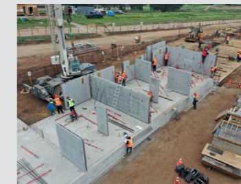
Caso Sistema industrial de construcción robotizada de hormigón armado - Baumax Link(s) de interés: www.baumax.cl
