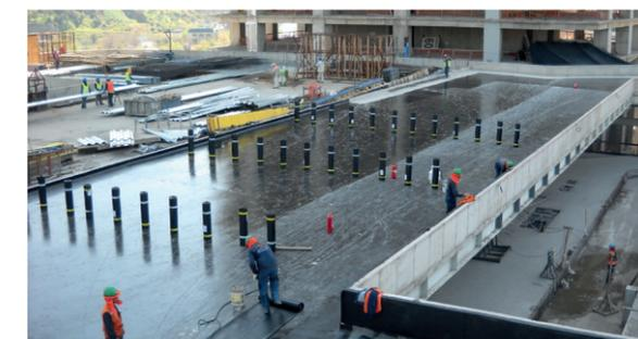
**Ilustración 99.** Impermeabilización de una cubierta en un centro comercial
