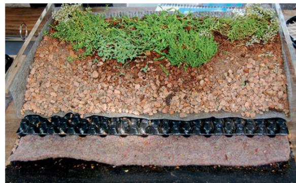
Ilustración 38. Muestra constructiva de una cubierta vegetal extensiva.
