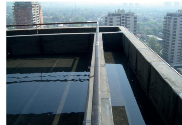
**Ilustración 119.** Prueba de agua por inundación
