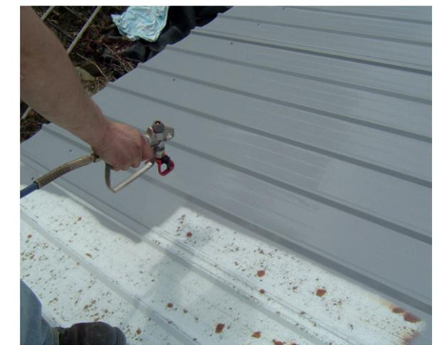
**Ilustración 132.** Impermeabilización y saneamiento de una cubierta metálica oxidada
