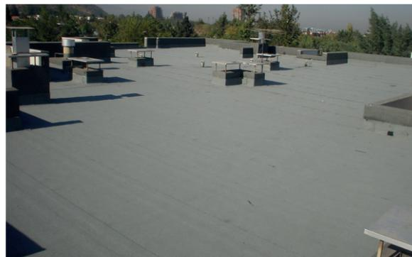
Ilustración 1. Cubierta plana con impermeabilización asfáltica.
