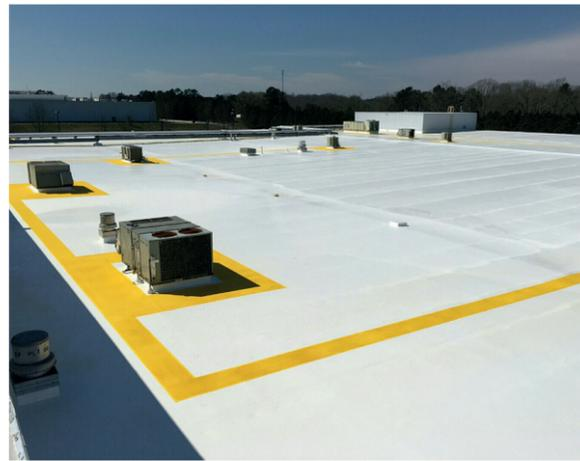
Ilustración 34. Cubierta con recubrimiento de silicona
