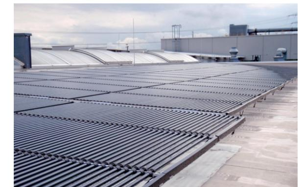
**Ilustración 5.** Sistema solar térmico sobre cubierta plana impermeabilizada
