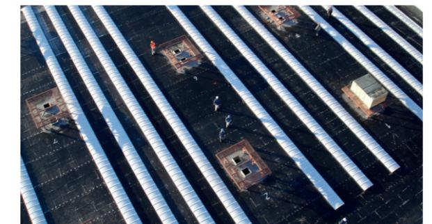
Ilustración 32. Cubierta con membrana de EPDM
