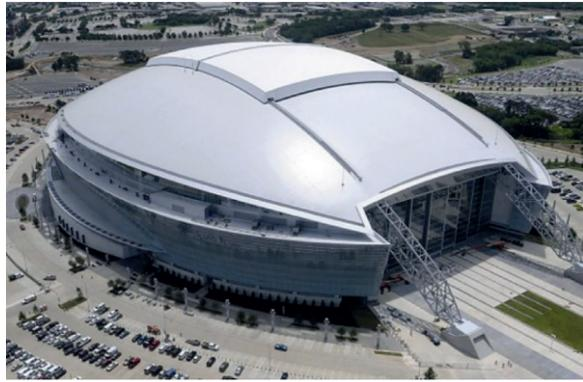
**Ilustración 6.** Cubierta del estadio Cowboys Arlington, Texas, EE.UU. con membrana de PVC, 2009.
