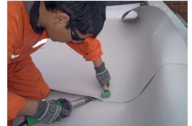
Ilustración 30. Instalación de una membrana de PVC
