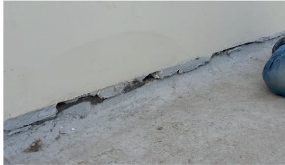
**Ilustración 127.** Falla en el encuentro entre cubierta y antepecho perimetral
