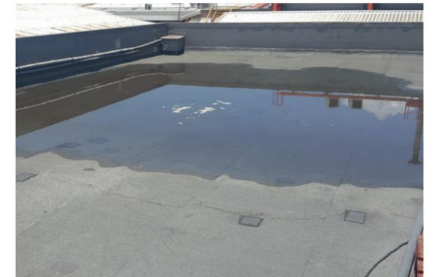
Ilustración 123. Empozamiento en cubierta por desagüe inefectivo (a la izquierda).
