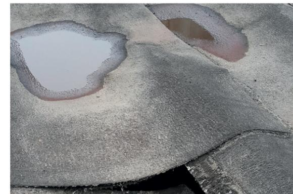
Ilustración 122. Membrana asfáltica sobre soporte inadecuado
