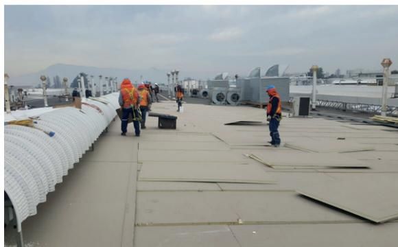
Ilustración 37. Instalación de aislamiento térmico PIR
