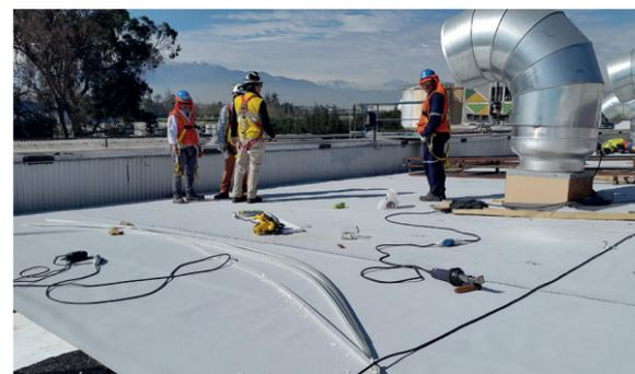
Ilustración 103. Impermeabilización de una cubierta en una planta industrial
