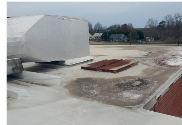
**Ilustración 18.** Cubierta con agua empozada sobre impermeabilización líquida
