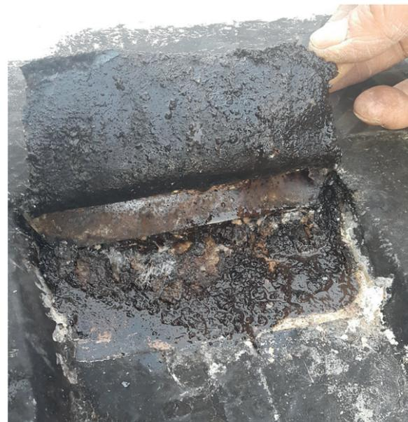
**Ilustración 131.** Falla en la reparación de un techo metálico mediante membrana asfáltica
