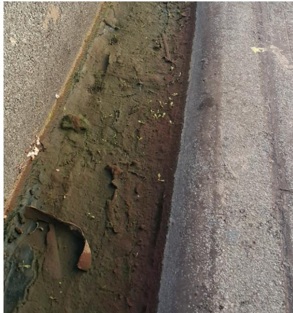
Ilustración 121. Canal de aguas lluvia sin mantención
