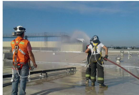
**Ilustración 118.** Prueba de agua con chorro de agua
