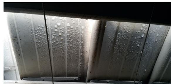
**Ilustración 128.** Condensación en la cara interior de una cubierta metálica
