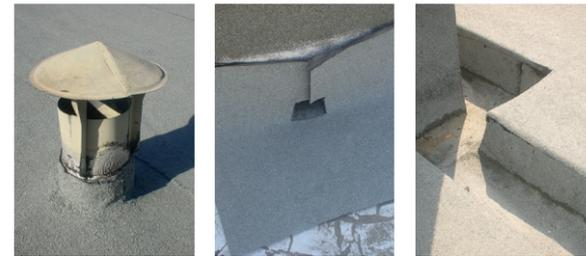
Ilustración 90. Detalles constructivos con membrana asfáltica.
