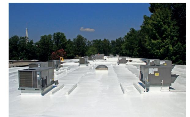
Ilustración 2. Cubierta plana con impermeabilización polimérica líquida.
