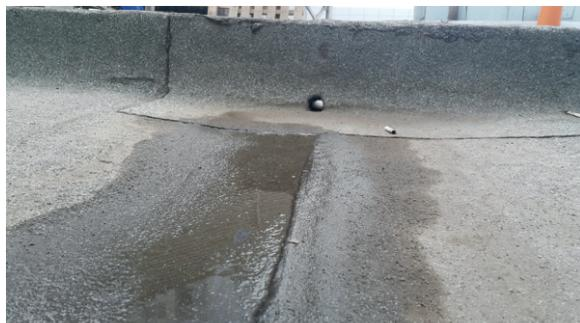
**Ilustración 124.** Desagüe subdimensionado y empozamiento en membrana asfáltica
