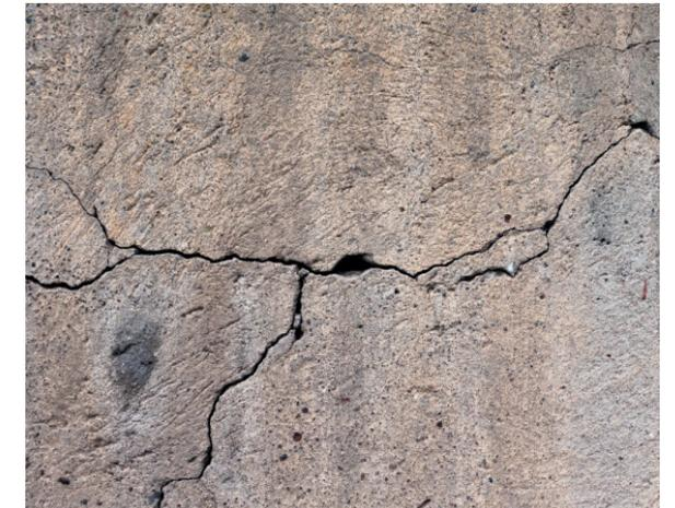
**Ilustración 111.** Sustratos con grietas y fisuras requieren un adecuado tratamiento previo.
