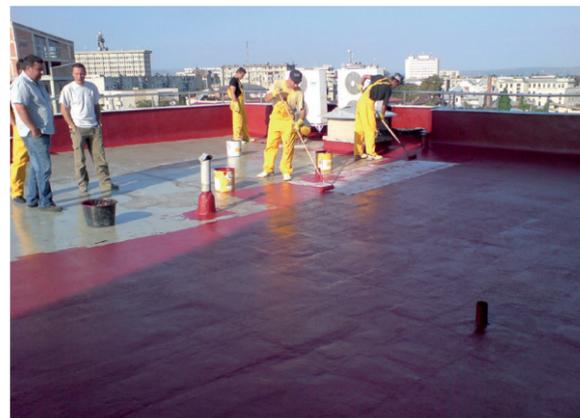
Ilustración 33. Instalación de una membrana líquida acrílica
