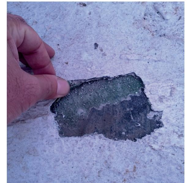
**Ilustración 126.** Falla de una membrana preformada vinílica
