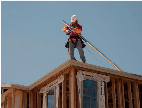
**Ilustración 107.** Trabajador con Equipamiento de Protección Personal adecuado.
