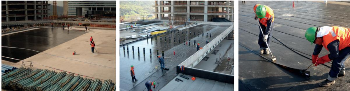
Ilustración 112. Instalación de membrana asfáltica
