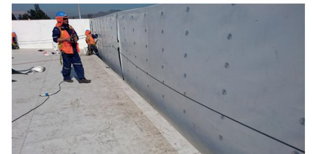
Ilustración 31. Instalación de una membrana TPO en superficie horizontal y vertical.
