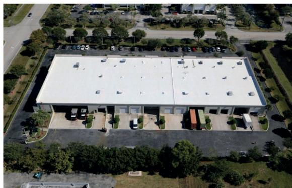
Ilustración 135. Centro de distribución con "cool roof"
