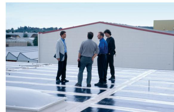
**Ilustración 44.** Membrana polimérica con módulos fotovoltaicos flexibles integrados
