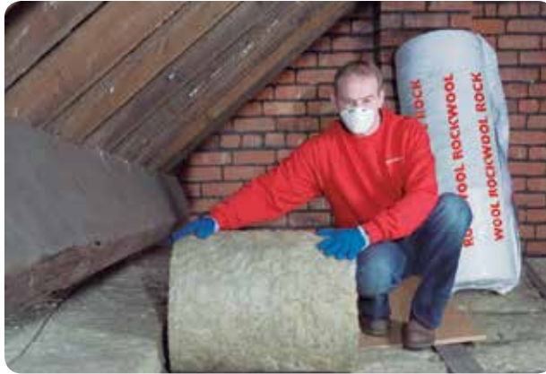
Figura 5.23: Instalación del aislante entre y sobre las vigas en techumbre fría.
