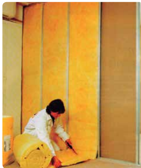
Figura 5.28: Asentamiento del material aislante en un muro
