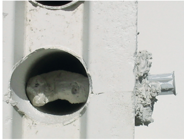
Figura 8.6. Instalación de fijaciones en tabiques de bloques de yeso.
