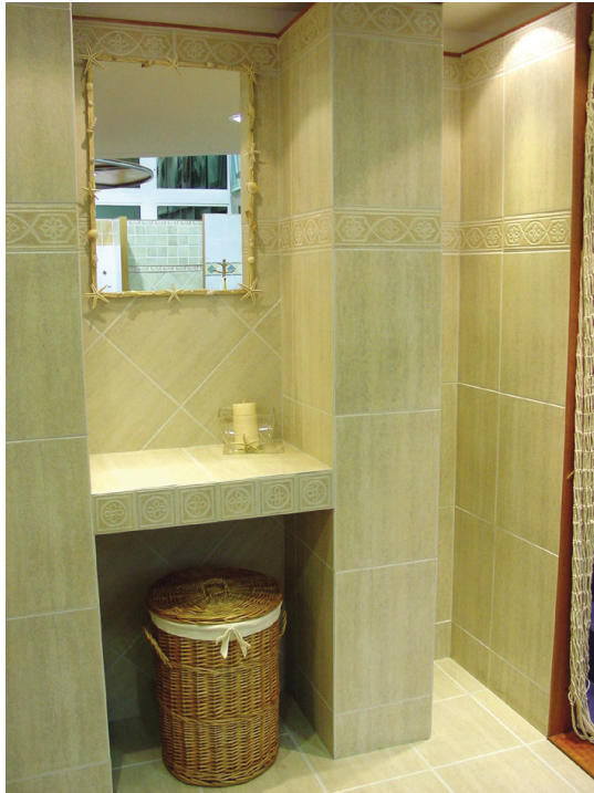
Figura 5.6. Correcta instalación de cerámica en recinto húmedo.
