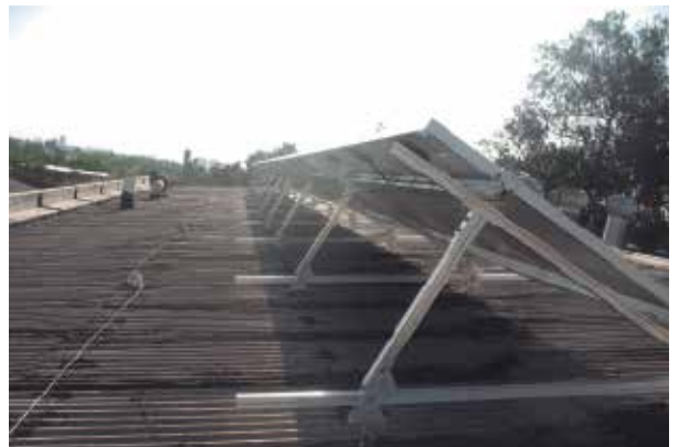
FIGURA 3.7 Detalle del Montaje de los Módulos. Se aprecia el montaje en la estructura, sin realizar las conexiones eléctricas. Fuente: Proyecto de Generación Fotovoltaica Chilectra - UTEM.
