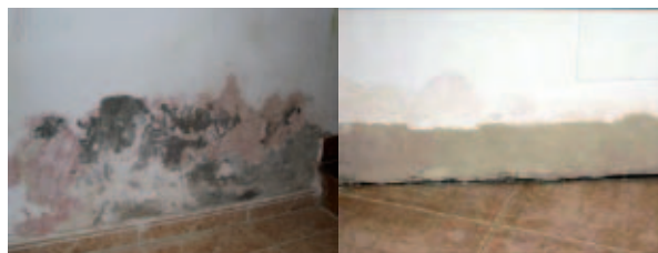
Figura 1.2. Humedad por capilaridad.
