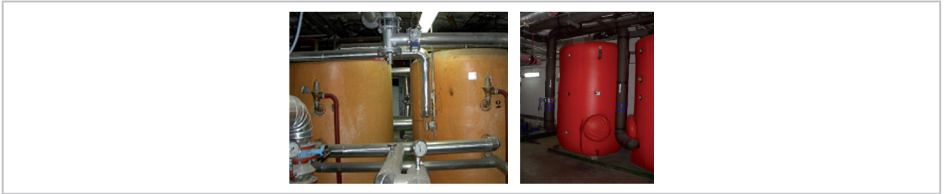
FIGURA 8-9 EJEMPLOS DE SISTEMAS DE ACUMULACIÓN EN ESPACIOS INTERIORES
