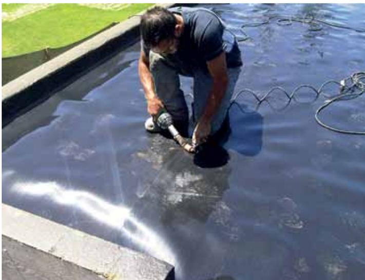
Imagen 6.5 Instalación de Protección Anti-raíz ( Imagen gentileza Tecpro)
