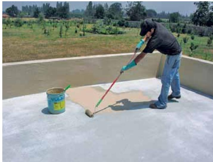
Imagen 6.4 Aplicación de Membrana de Poliuretano (Imagen gentileza Tecpro)
