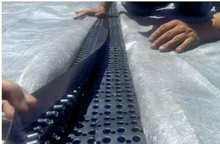
Imagen 6.10 Instalación de la capa de acumulador de agua (Imagen gentileza Tecpro)
