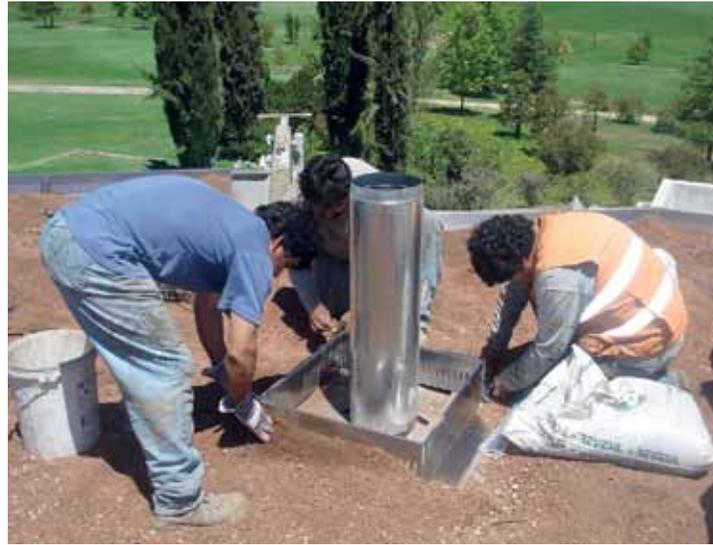
Imagen 6.11 Instalación de Retenedores perimetrales (Imagen gentileza Tecpro)
