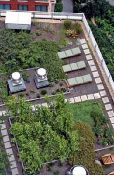
estos marcos. De ninguna manera deberán ser anclados mecánicamente a la estructura soportante, a no ser que existiera un elemento previamente instalado y correctamente sellado e impermeabilizado especialmente previsto para eso.
