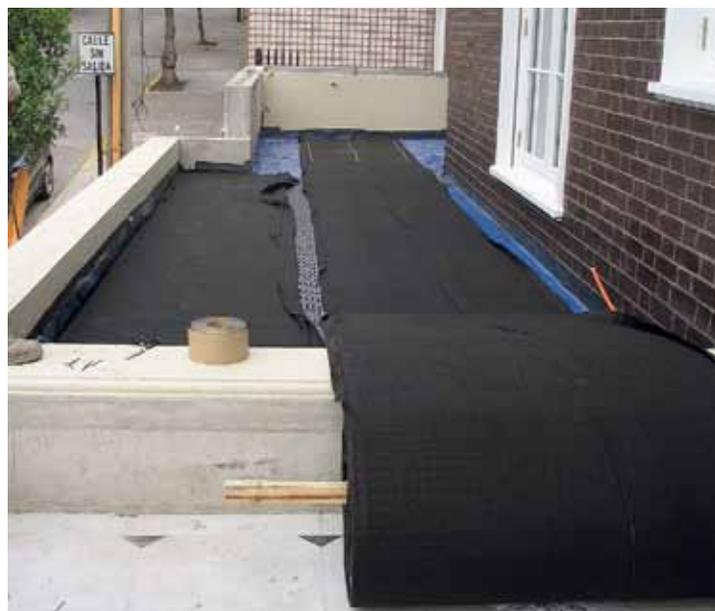
Imagen 6.7 Instalación de la capa de Drenaje (Imagen gentileza Tecpro)
