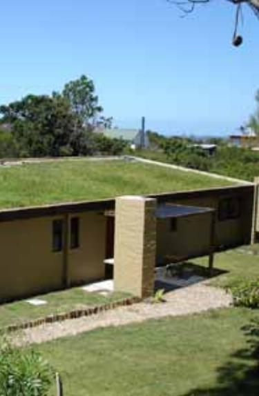
En zonas tránsito deben diseñarse protecciones adecuadas para evitar daños mecánicos. Puede ser aplicado sobre planchas de poliestireno expandido o poliuretano rígido, colocando una capa separadora de polietileno.
