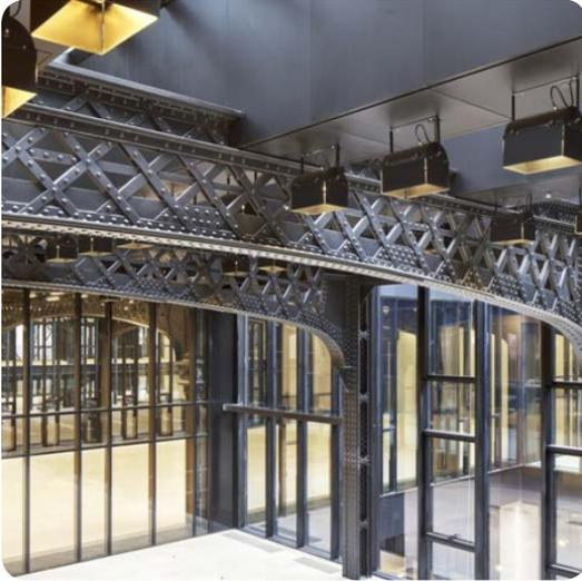
A obra de Perrault consiste en la restauración de las estructuras industriales de acero del siglo XIX, contemporáneas a la Torre Eiffel. Su diseño se caracteriza por arcadas sostenidas por potentes contrafuertes y armazones metálicos de tipo Eiffel en grandes vanos.
