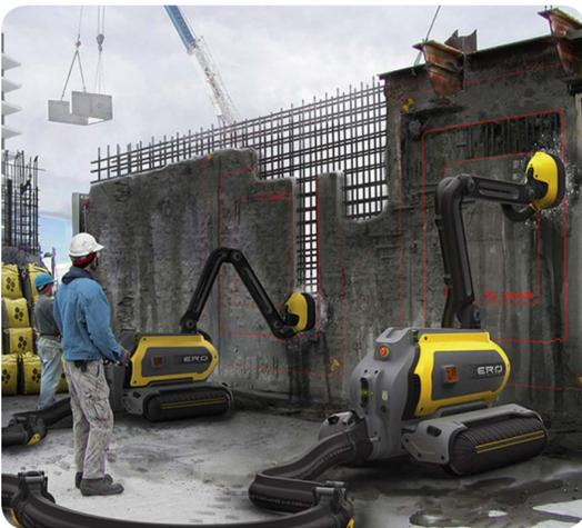
Diseño de Robot para la deconstrucción inteligente, tiene como función separar el hormigón de las barras de refuerzo, transformándolo en trozos pequeños para luego transportarlo a estaciones de reciclaje en las que el hormigón se pulveriza y el metal se funde. Este diseño permite desmontar el material sin residuos, polvo o separación adicional, potenciando la recuperación eficiente del material para utilizar en otros procesos constructivos.
