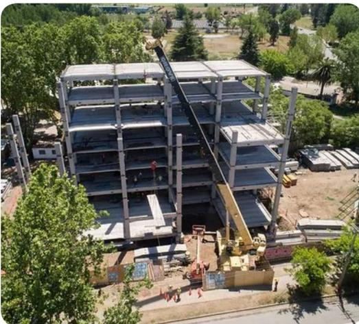
TENSOCRET ha sido pionero y posee un equipo de profesionales de reconocida experiencia en edificios prefabricados con sistemas de protección sísmica basal. Es un sistema constructivo abierto y flexible compuesto por elementos prefabricados en hormigón que permite abarcar soluciones para diversos segmentos de edificación pudiendo incorporarse sistemas de protección sísmica basal entregando un alto estándar estructural a sus edificios. (Corporación de Desarrollo Tecnológico, 2020)
