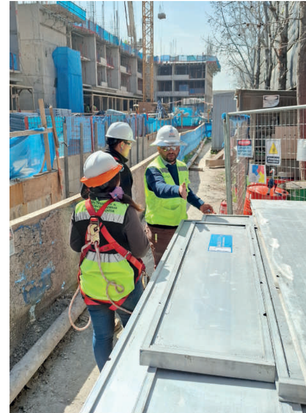
Fuente: Euro Constructora, Proyecto Independencia
