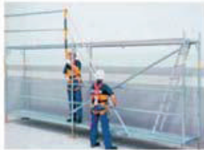
Colocar el pie de seguridad desde el nivel protegido.*
