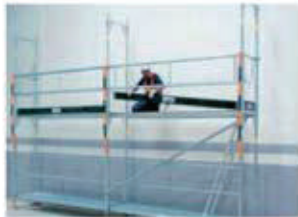
Colocar las barandillas y los rodapiés.
