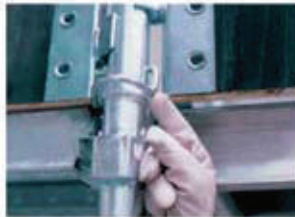
Colocar los pasadores de seguridad y amarrar a la fachada.
