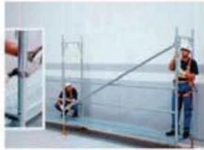
Colocar la diagonal con abrazadera.
