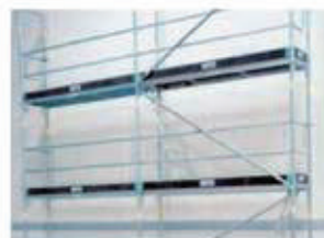
Colocar los marcos, las barandillas, los rodapiés y la diagonal.
