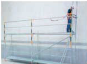
Colocar los marcos. Utilizar protección individual.
