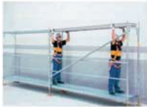
Colocar las plataformas y sus pasadores de seguridad.
