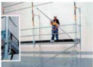
Colocar las diagonales. A partir del segundo nivel los enganches son a punto fijo.
