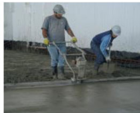
Un riguroso proceso de hormigonado fue realizado para lograr planitud y resistencia a bajas temperaturas.
