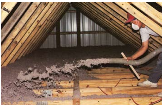
Proyección de celulosa aislante en un ático de vivienda.
