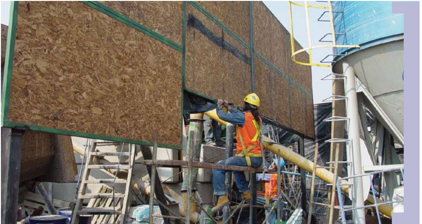
Las barreras acústicas emplean distintos materiales como planchas de OSB. Además, al interior se pueden reforzar con elementos aislantes como lana mineral.
