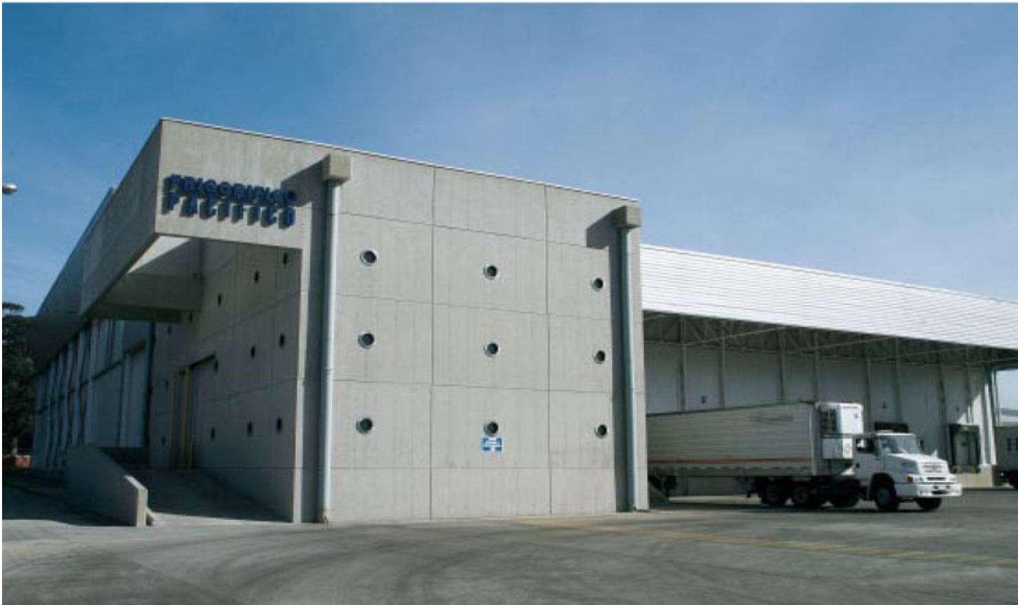
Frigorífico Pacífico está conformado por 4.954 m 2 principalmente de hormigón visto, estructuras de acero y paneles aislantes.
