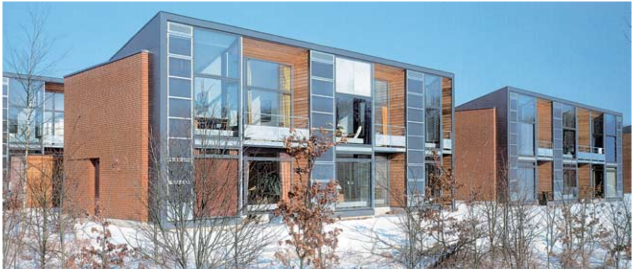
Conjunto de viviendas en Dinamarca: Las casas disfrutan de orientación norte-sur, los muros norte constan de aislamiento y la fachada sur está completamente acristalada y aislada.
