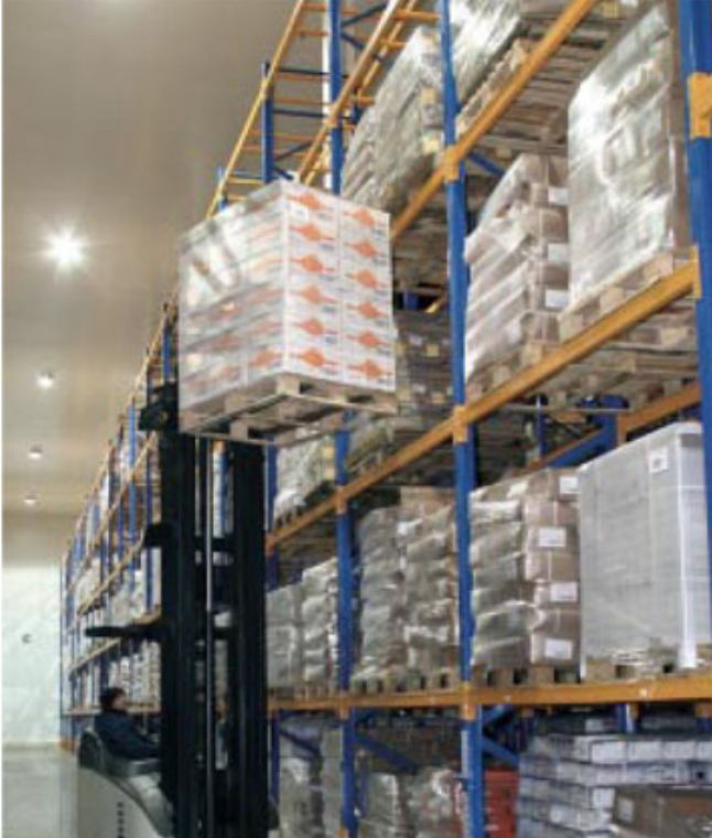
La lisura y planitud de los pavimentos fue lograda gracias a las exigencias de las especificaciones técnicas. Se consiguió una óptima velocidad de desplazamiento de los apiladores y transpaletas.
