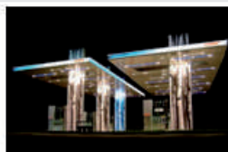
Copec Marquesinas Costanera Norte Sabbagh Arquitectos
