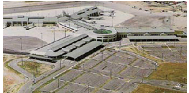
Aeropuerto Piarco International Airport en Port of Spain, Trinidad y Tobago. Capas múltiples de impermeabilizantes asfálticos SBS FR, SBS PolyBase y MB Base instalados con asfalto caliente. Aislado con aislante térmico FIRESTONE ISO Nailbase de 76,2mm (3,0") de espesor. Tamaño: 28,800m 2 (310,000ft 2 )
