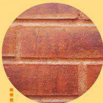
Ladrillo bien protegido
