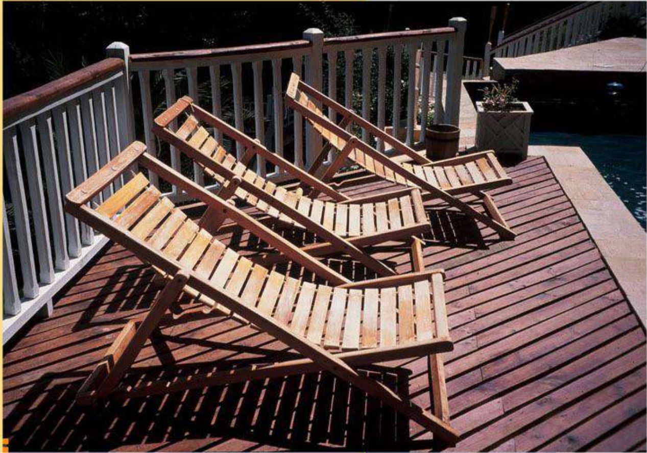
Muebles dañados barnizados con barniz marino y pisos protegidos con impregnantes para maderas, Stain.
