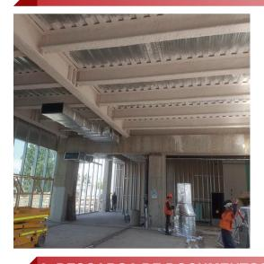
El mortero IGNIVER se aplica por vía húmeda mediante máquina de proyección. Consultar la tabla de masividades para determinar el espesor de aplicación en cada caso www. volcan.cl/igniver.
