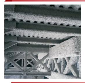
El Mortero para protección de túneles, compuesto de de roca, cemento y material refractario en pequeñas lana proporciones, ha sido diseñado específicamente para la protección contra el fuego en industrias.
